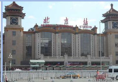
La gare de Pékin sous surveillance policière permanente.
